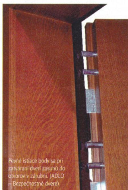
Pevné istiacie body sa pri zatváraní dverí zasúvajú do otvorov v zárubni. (ADLO – Bezpečnostné dvere)
