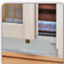
Príklad uzamknutia balkónových dverí, spodný protikus
