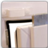
Uzamykací mechanizmus okna, horný protikus
