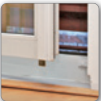
Príklad uzamknutia balkónových dverí, spodný protikus
