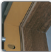
ADLO drážkové tesnenie v Exteriérovej TERMO zárubni
