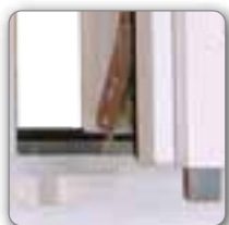
Uzamykací mechanizmus okna, spodný protikus
