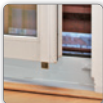
Príklad uzamknutia balkónových dverí, spodný protikus
