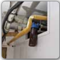
Prispôbenie pivničným rozvodom
