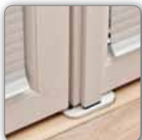
Príklad uzamknutia balkónových dverí, spodný protikus
