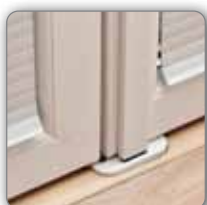
Príklad uzamknutia balkónových dverí, spodný protikus
