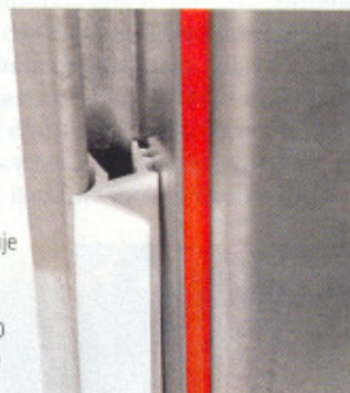
Istiaci bod zabetónovaný do podlahy sa považuje za neprekonateľný. (ADLO – Bezpečnostné dvere)
