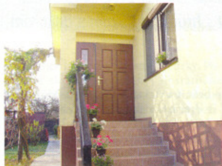
Bezpečnostné dvere rodinného domu so svetlíkom na ľavej strane (ADLO – Bezpečnostné dvere)
